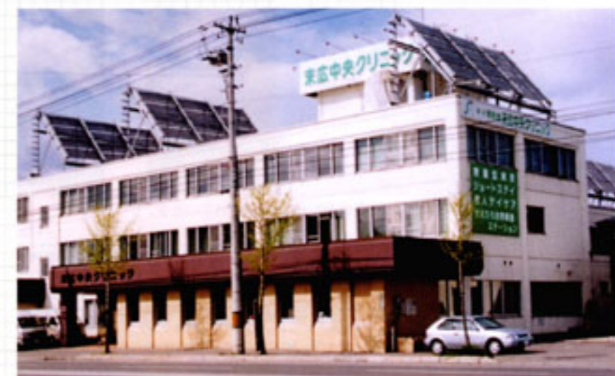
末広中央クリニックに設置されているソーラーシステム
